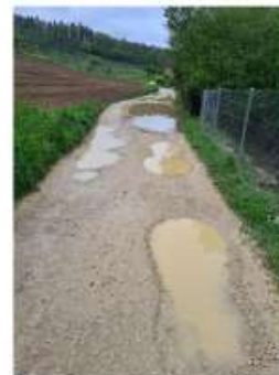
Situation bei regnerischem Wetter, 24.04.2024
